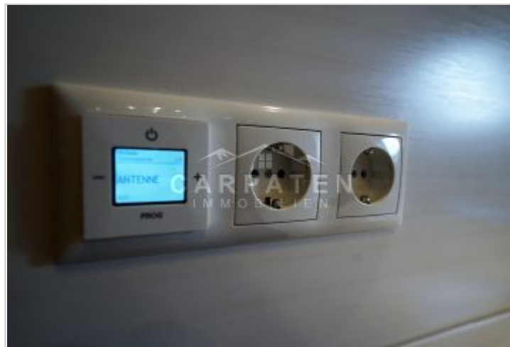
Radio Badezimmer DG
